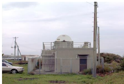
漁港管理者以外が所有する漁港施設の例(漁港浄化施設)
